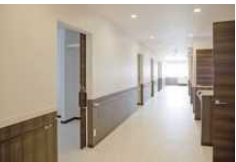
連続手摺の廊下
